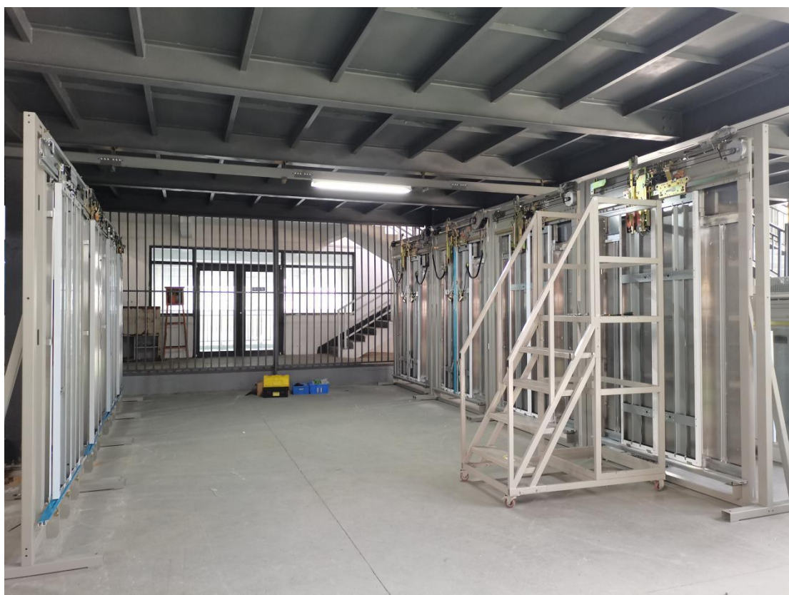
图 6：电梯厅门与轿门系统模块实训区
